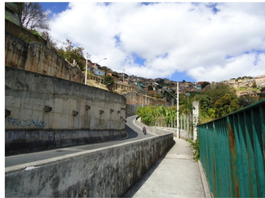
Contenções geradas para a abertura da Via do Cardoso
